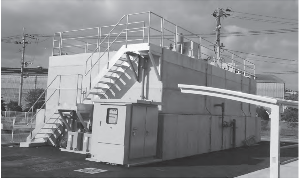
排水処理施設
