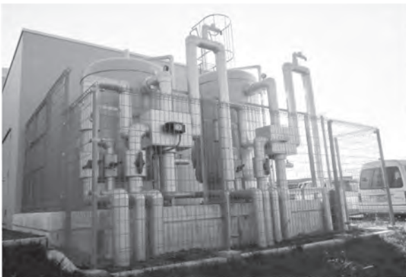
中水装置(砂ろ過・活性炭ろ過)
